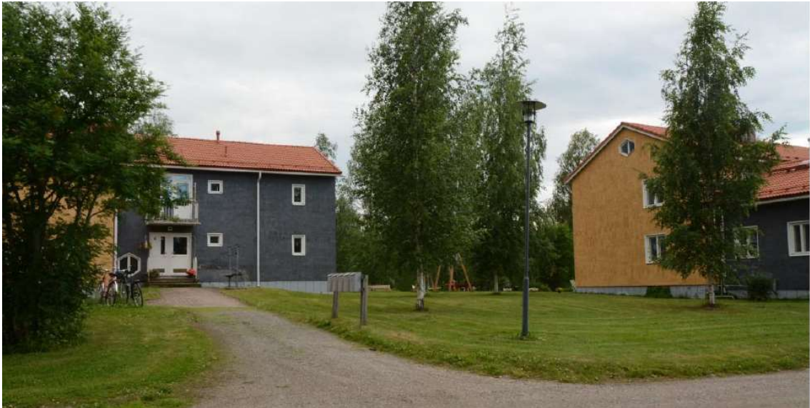
KUVA 19: Rakennukset A ja B kuvattuna idästä.
