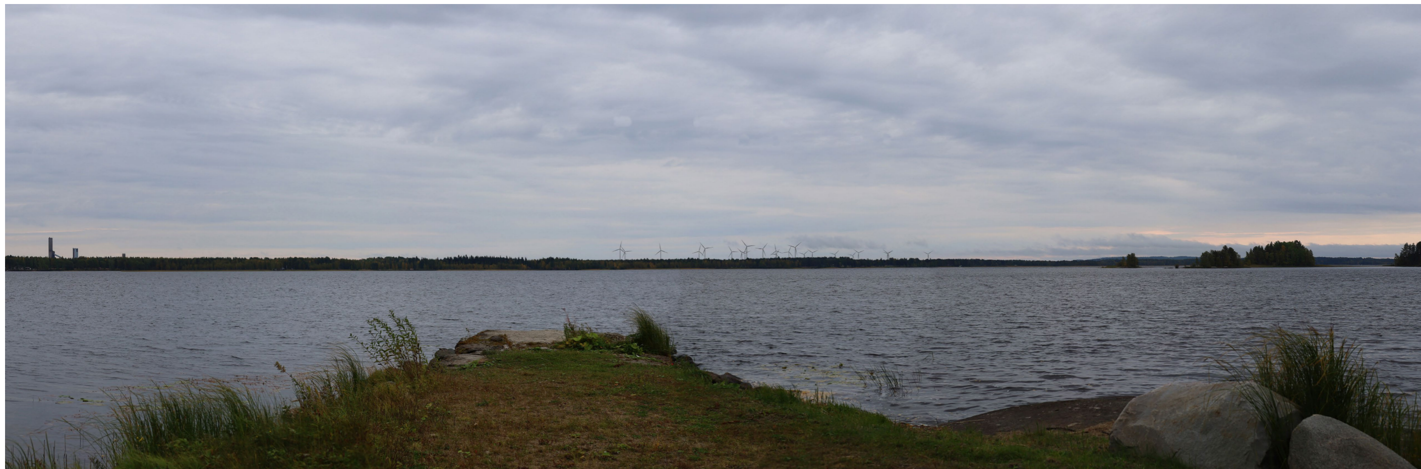
Kuvauspaikka 24 Pyhäjärven ja Kiuruveden voimaloiden yhteisvaikutus. Koostettu panorama, kuvattu 50 mm polttovälillä. Voimaloiden kokonaiskorkeus 320 m. Etäisyys lähimpään voimalaan noin 11,3 km.
