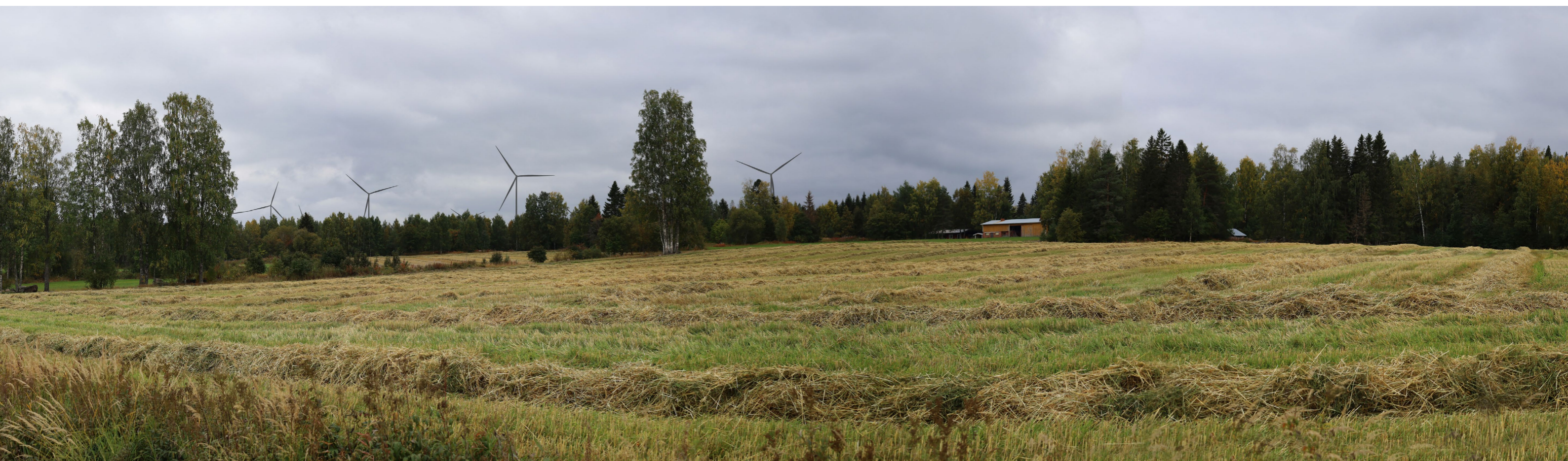
Kuvauspaikka 10 Kaavartekniset tuulivoimalat, Kiuruvesi. Koostettu panorama, kuvattu 50 mm polttovälillä. Voimaloiden kokonaiskorkeus 320 m. Etäisyys lähimpään voimalaan noin 2,5 km.
