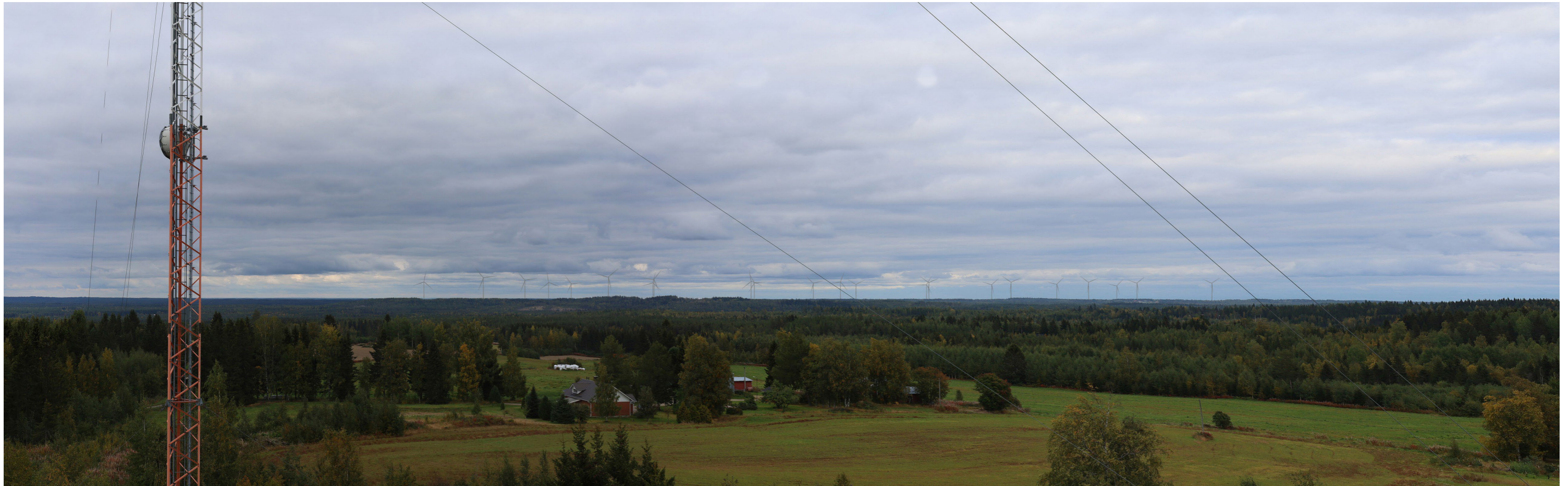
Kuvauspaikka 16 Pyhäjärven ja Kiuruveden voimaloiden yhteisvaikutus. Koostettu panorama, kuvattu 50 mm polttovälillä. Voimaloiden kokonaiskorkeus 320 m. Etäisyys lähimpään voimalaan noin 9,4 km.
